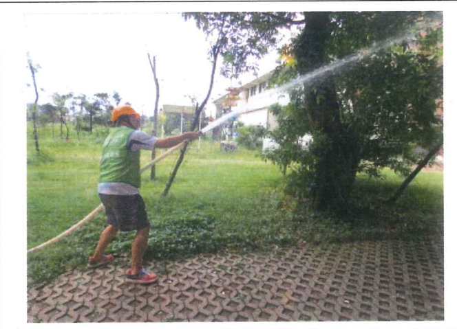
地點：高中部大樓旁 時間：104.9.16 說明：消防栓測試使用。
